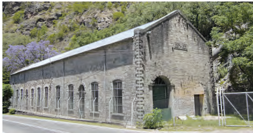
Estado actual de la usina. En 1901 se amplió el edificio y se le colocaron dos generadores más.
