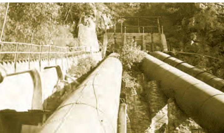
Tres cañerías de presión descendían desde la pileta de carga, ubicada a la salida del túnel, hasta las válvulas.
