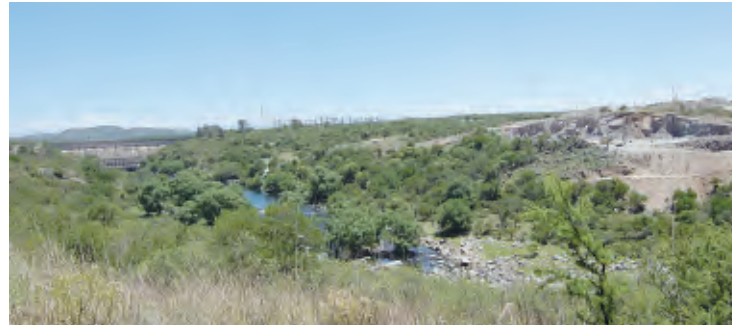
El dique y la usina Reolín. Pocos metros más adelante, se encuentra la zona de explosiones de la cantera.
