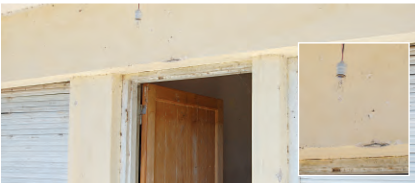
Las casas del barrio frente a la cantera, presentan impactos de rocas luego de las explosiones (detalle).
