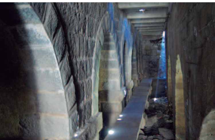
Detalle de los antiguos conductos de descarga del agua turbinada que desembocan en el río Suquía.
