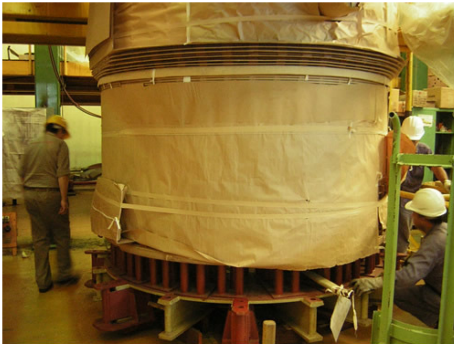
Construcción de transformadores de medición de ET Arroyo Cabral
